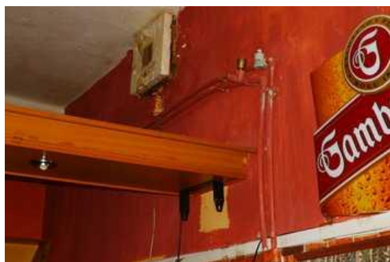
Instalace v budově
