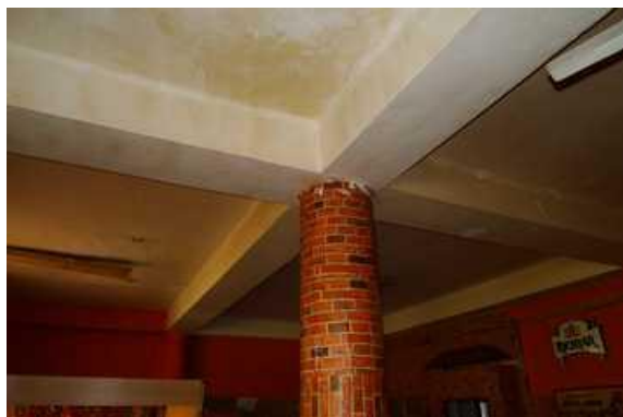
Nosný železobetonový sloup stropní konstrukce
